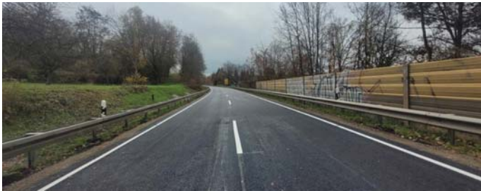
Fertiggestellte Fahrbahn B 39 Richtung Wiesloch, © RPK
